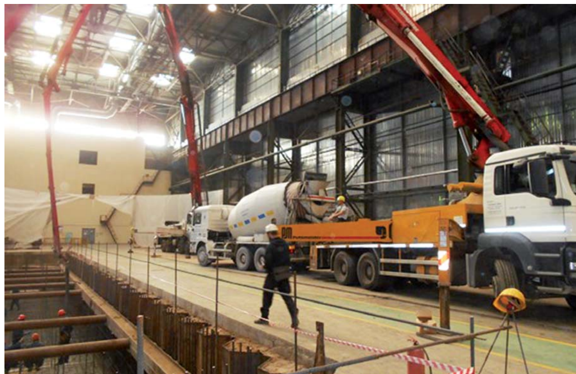
Устройство фундамента под горизонтальный токарный станок SKODA OM3-Sпецсталь в цехе №66
