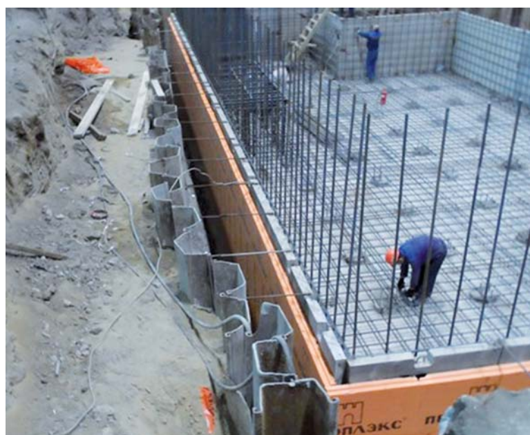
Устройство фундаментов для станков модели PAMA SPEEDRAM 3000 в цехе №2 ИЗ-КАРТЭКС имени П.Г. Коробкова
