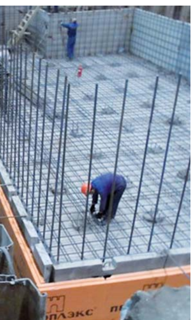
Устройство фундаментов для станков модели PAMA SPEEDRAM 3000 в цехе №2 ИЗ-КАРТЭКС имени П.Г. Коробкова
