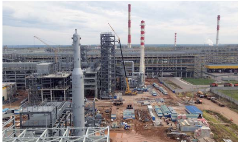
Монтажная площадка компании «Татнефть» им.В.Д.Шашина
