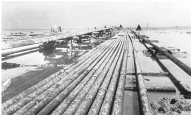
Строительство Ладожского трубопровода. Собранные в секции ижорские трубы на испытательном стенде. Май 1942 г.
