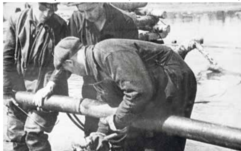
Стыковка и сварка секций Ладожского трубопровода. Май 1942 г.
