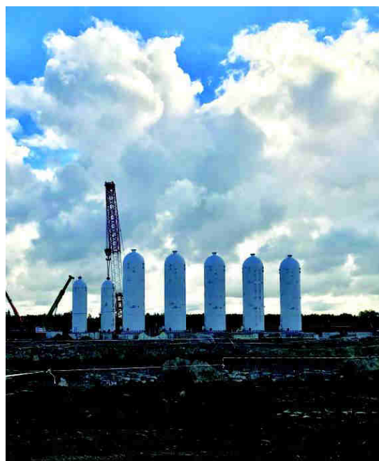
Монтаж адсорберов на площадке заказчика
